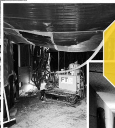
Réalisation d'une RSO par micropieux depuis un sous-sol aménagé avec une faible hauteur sous plafond et un vide sanitaire
