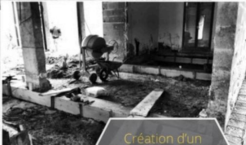
Création d'un plancher porté sur micropieux nécessitant la réfection complète du rez de chaussée
