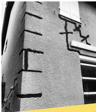
Réalisation de tirants afin de bloquer la fondation sur un terrain en pente
