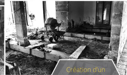
Création d'un plancher porté sur micropieux nécessitant la réfection complète du rez de chaussée
