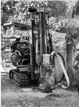
Dans le cas de reprise en sous oeuvre les micropieux restent la solution la plus adaptée par sa simplicité de mise en oeuvre. Elle reste également pérenne et permet de s'affranchir à coup sûr des variations hydriques.
